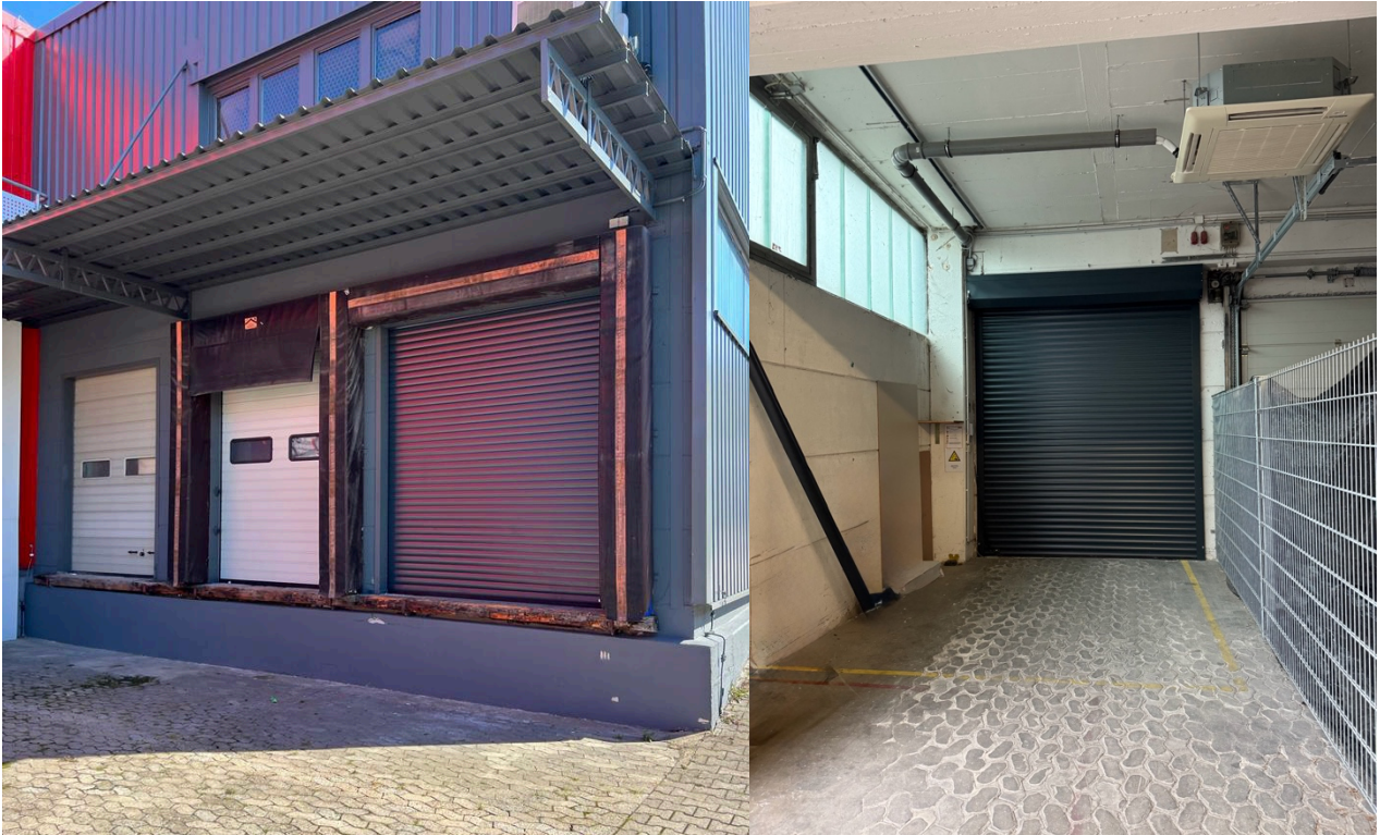
Abb. Laderampe (außen und innen)
