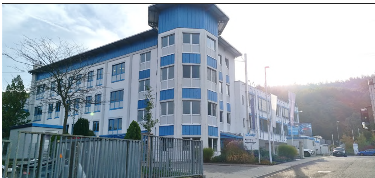
Bild 3: Verwaltungsgebäude / Westecke des Planbereichs, Blick in Richtung Südosten – Quelle: ibu-GmbH
