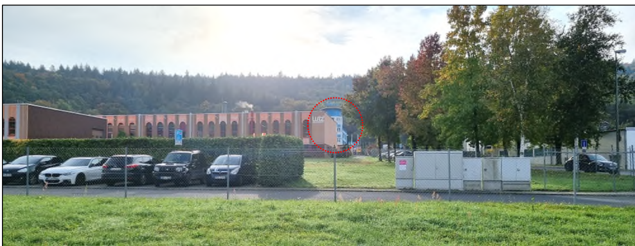
Bild 10: Blick auf den Gebäudekomplex der Fa. König GmbH & Co.KG (rot eingekreist) in Richtung Südosten, Standort in der Straße „Am Kreuzeck“
