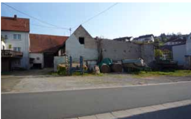
Abb. 28 Beispiele für den zunehmenden Verfall der Ortskerne durch Leerstände und Verschlechterung der Bausubstanz (Poppenlauer, Wüstenzell)
