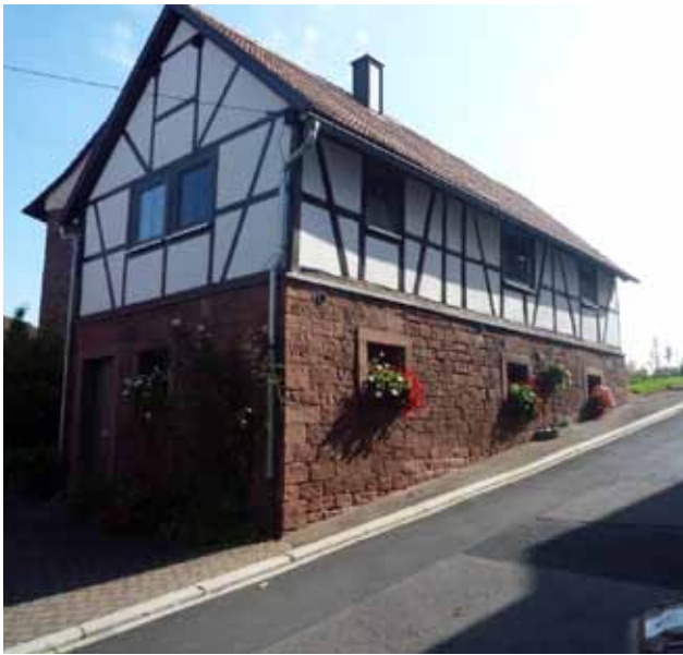
Abb. 53 Scheune in Fachwerk mit Natursteinsockel
