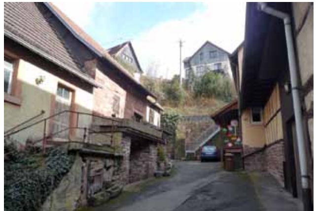
Abb. 45 Kleine Grundstücke, dichte Bebauung, Erschließung und Bauzustand mangelhaft
