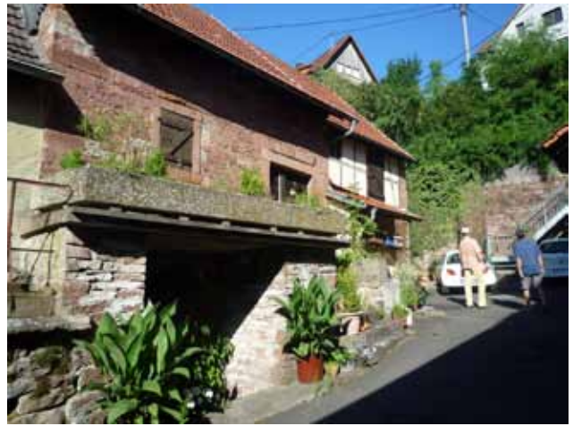
Abb. 60 Gustav-Rommel-Straße 18 und 16a: erhaltenswerte aber sanierungsbedürftige Bausubstanz
