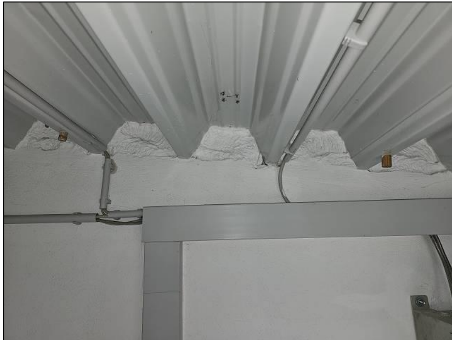
Abb. 5: Dachgeschoss in Bestandsgebäude (18.09.2024)
