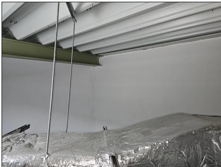
Abb. 6: Dachgeschoss in Bestandgebäude (18.09.2024)
