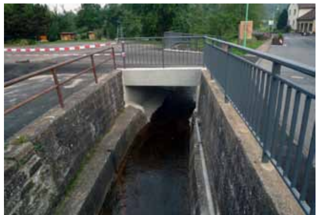
Abb. 13 Verrohrter Bachlauf im Ortsbereich
