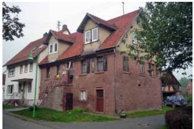
Abb. 45 Ortstypische Bausubstanz, Sanierungsbedarf
