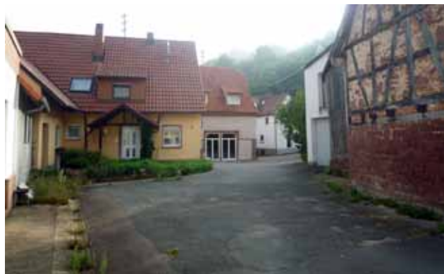
Abb. 55 Dichte Bebauung ohne definierte Erschließung
