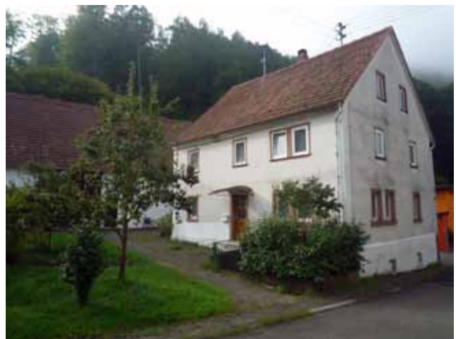
Abb. 40 Leerstehendes Wohnhaus Quellenstraße
