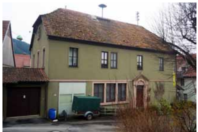
Abb. 18 Denkmalgeschütztes Gebäude mit veränderter Fassade
