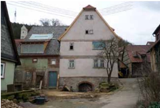
Abb. 57 Rainbachstraße 21 während der Sanierung
