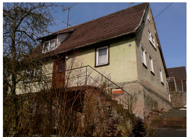
Abb 16: Im Ortskern: leerstehendes Wohnhaus
