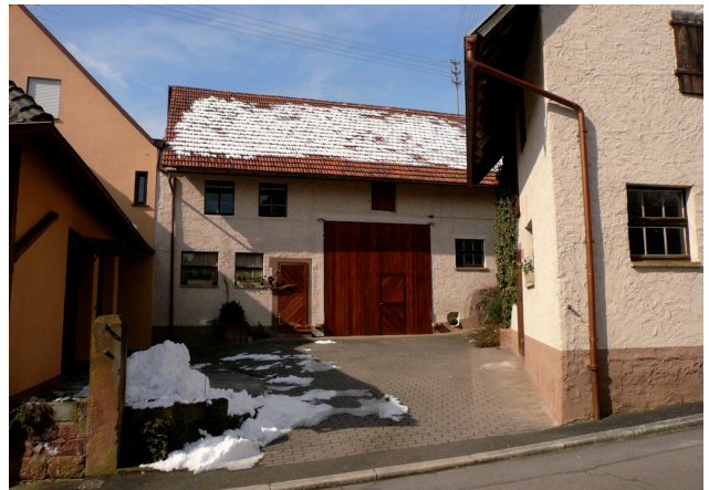
Abb 18: Weitgehend versiegelte Hofflächen
