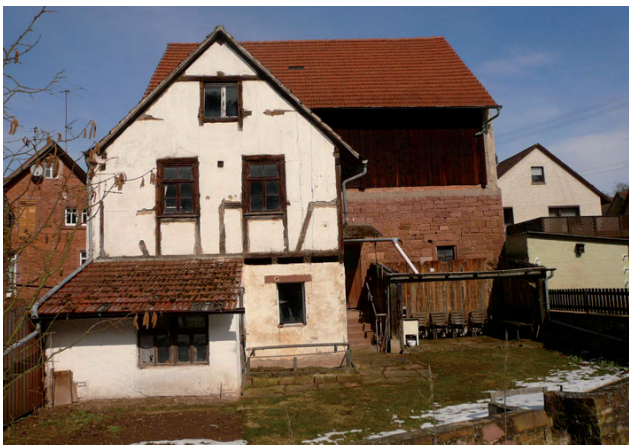
Abb 26: Alte Hofstelle: attraktive Lage, schlechter Erhaltungszustand
